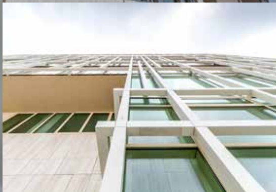
Edificio direzionale e residenziale "Ex manifattura tabacchi" – BRESCIA Facciata ventilata in Travertino Classico, rivestimenti e pavimentazioni in Botticino Classico
