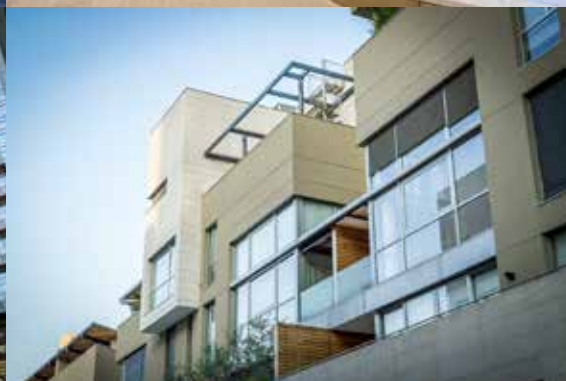
Nuovo complesso residenziale e terziario "Corso Como" – MILANO Facciata ventilata in Vratza, rivestimenti interni in Arabescato Corchia
