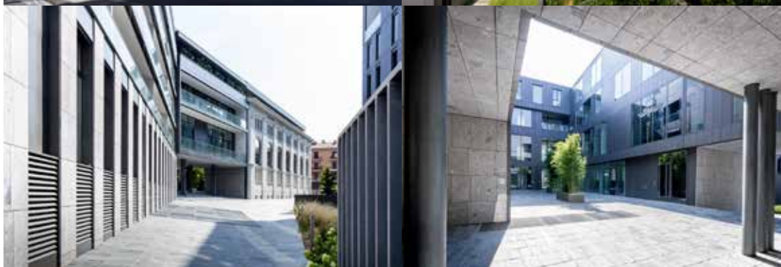
Edificio direzionale e residenziale "Ex sede Enel" – BERGAMO
